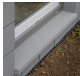
Betonové parapety venkovní
